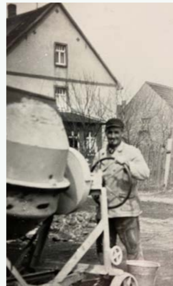
Ein Mitglied der PGH am Kipptrommelmischer. Die Möglichkeiten der PGH blieben Anfang der 1960er Jahre weit hinter der Nachfrage zurück. Foto: Sammlung Wichmann
