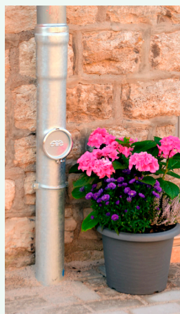
◀ Das grüne Übergangsstück ist hier vom Gehweg aus kaum zu erkennen. Für den Übergabesprung vom Durchmesser 70 Millimeter auf 100 Millimeter kann eine Rosette eingesetzt werden. Bei anderen Gebäuden ist das grüne Übergangsstück deutlich länger und sticht damit auch deutlicher ins Auge.
