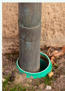
▲ Hier hat der Anwohner schon das Standrohr mit Revisionsklappe vorschriftsmäßig installiert. Das grüne Übergangsstück ist schon entfernt.
