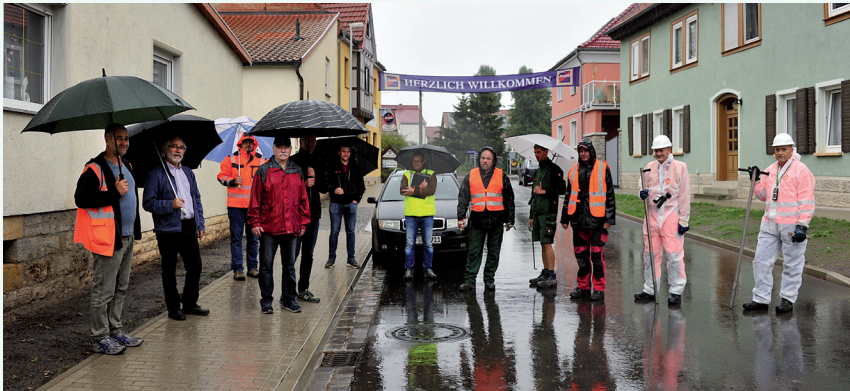
▲ Bei der Bauabnahme waren neben den Vertretern der Stadt Erfurt und des Baubetriebes Wagner Straßen- und Tiefbau GmbH auch zwei Vertreter aus Schwerborn vertreten, Reinhold Weber (4.v.l.) und René König (5.v.l.).
